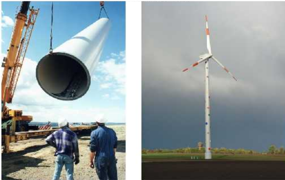
그림 49. 강재 Tubular 타워 시공 및 완성 모습
