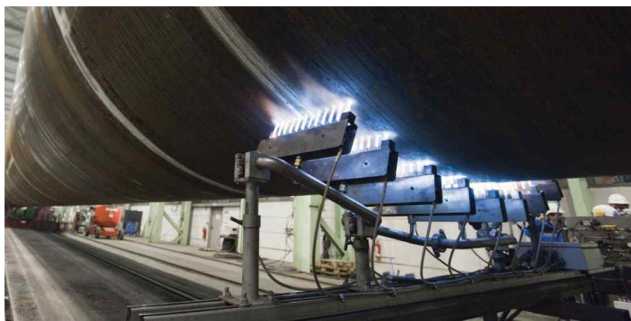
그림 28. 용접제작 대단면 후육강관의 자동화 후열처리 과정
