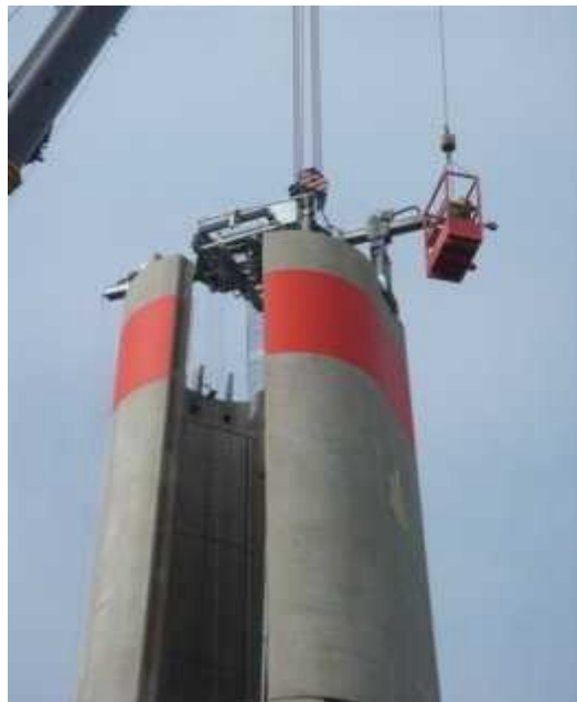
그림 37. 하부 콘크리트 타워 시공사례 (Netherland ATS사 사례)
