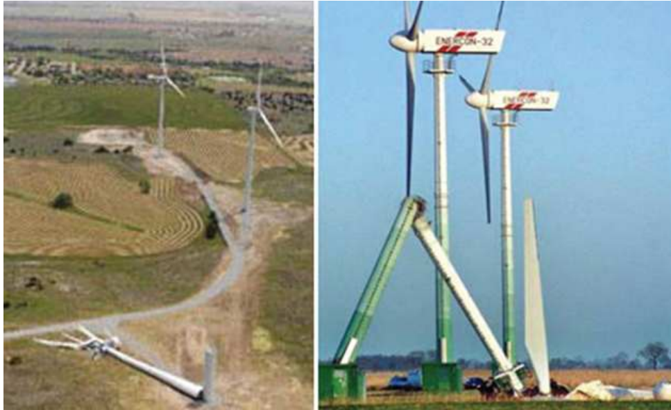
그림 2. 잦은 하중변화(좌)와 유지관리의 소홀(우)로 인한 타워 붕괴
