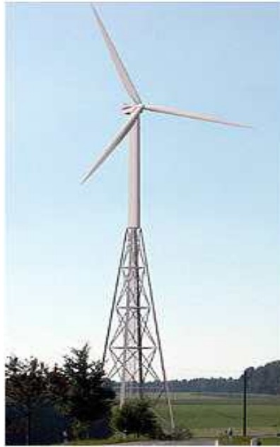
그림 40. Lattice-Tube 하이브리드 타워구조
