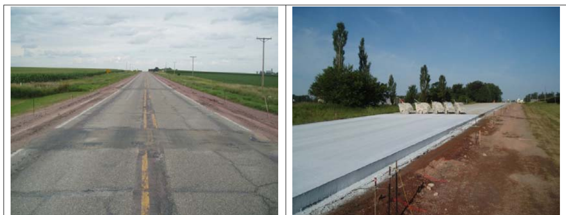
<그림 2.33> UBCO 설치 전후의 모습(IA 60)
