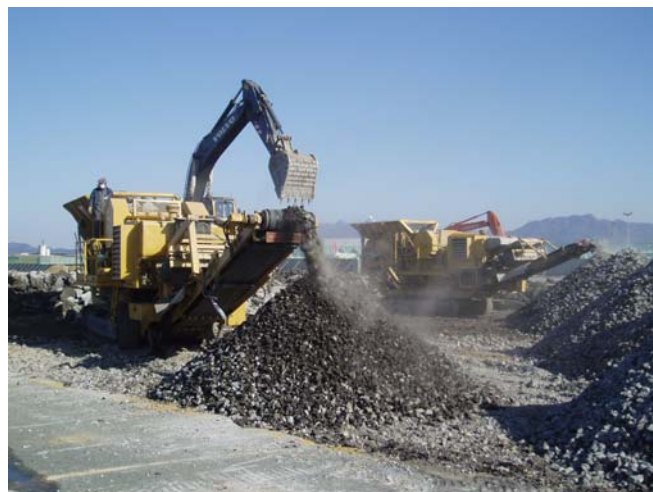
<그림 2.29> 김해기지 현장 크랏샤 전경
