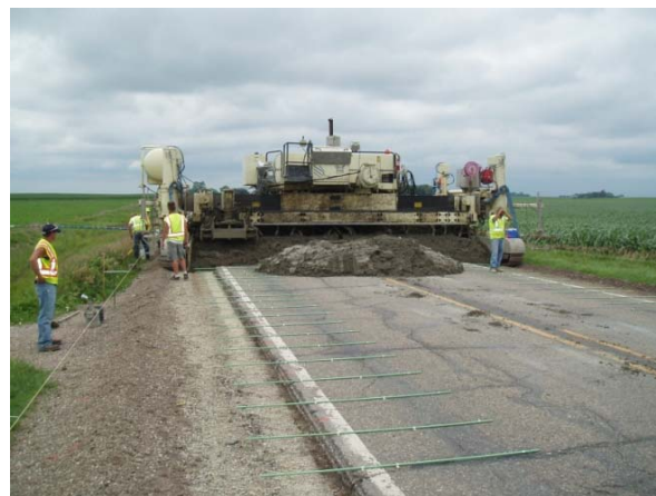
<그림 2.32> IA 60의 확장구간에 사용된 5ft 타이바 사용 모습
