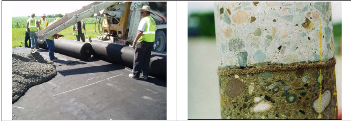
<그림 2.34> UBCO+토목섬유 분리층 시공 및 코어 시편(Klocke 등, 2010)
