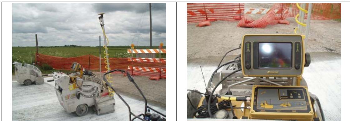
<그림 2.35> GPS 장비가 장착된 줄눈절단장비와 GPS 장비
