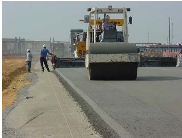
<그림 2.21> RCC 포장공법
