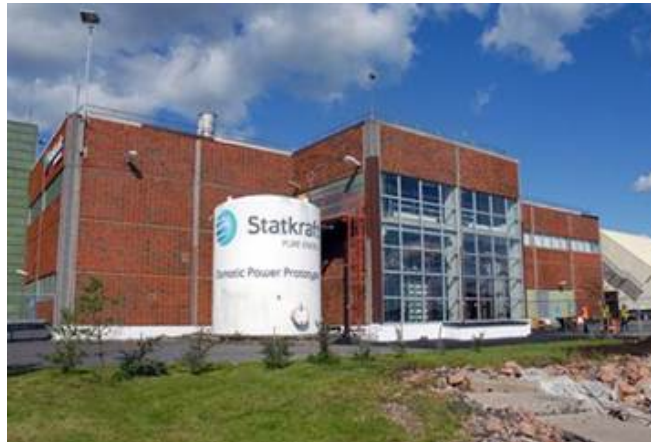
[그림 2-28] Statkraft 사의 PRO 파일럿 플랜트 전경 (Tofte, Norway)
