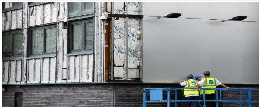
〈그림〉 글렌펠 타워 화재 후 외장재 테스트를 위해 철거작업 중인 모습
