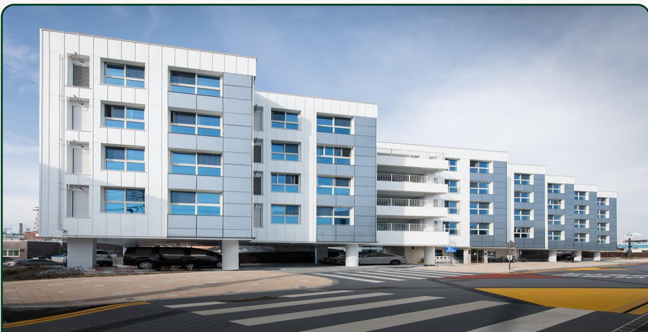
에너지자립형 ZEB* 3등급 공동주택 전경
