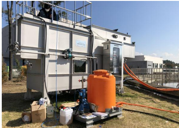
[그림] 저에너지 가압부상 분리시스템 설치 현장
