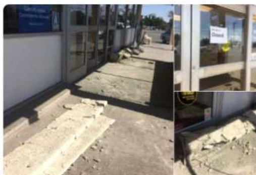
그림 15. (a) North Ridgecrest에있는 건물의 파손된 콘크리트 패널 (출처 : Karen Hua via Twitter); (b) 규모 6.4 지진으로 인한 리테일 건물의 유리 외관 파손 (출처 : AP)
