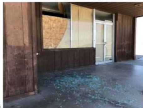
그림 15. (a) North Ridgecrest에있는 건물의 파손된 콘크리트 패널 (출처 : Karen Hua via Twitter); (b) 규모 6.4 지진으로 인한 리테일 건물의 유리 외관 파손 (출처 : AP)
