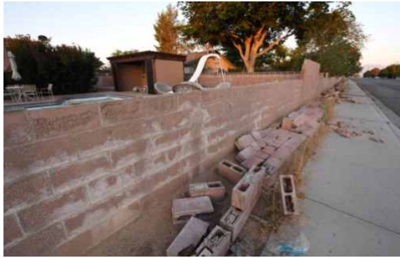
그림 19. 규모 7.1 지진 (CNN, 2019)에 따라 리지 크레스트에서 부분적으로 파괴된 콘크리트 블록 벽
