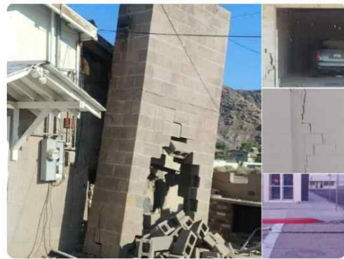
그림 20. M 7.1 지진 후 Trona의 석조 건물 손상 (출처 : Twitter를 통한 Eytan Wallace) (중략)
