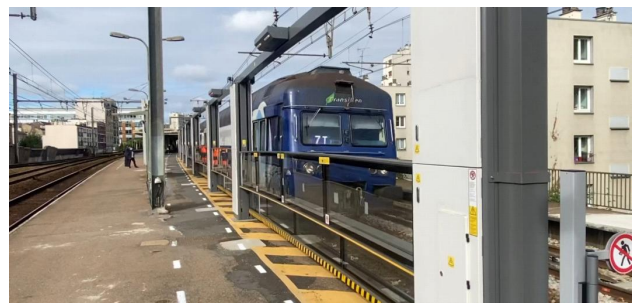
프랑스 방브스 말라코프역 설치 VPSD
