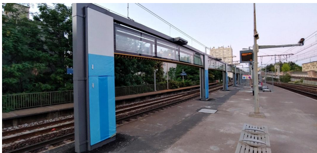
프랑스 방브스 말라코프역 설치 VPSD
