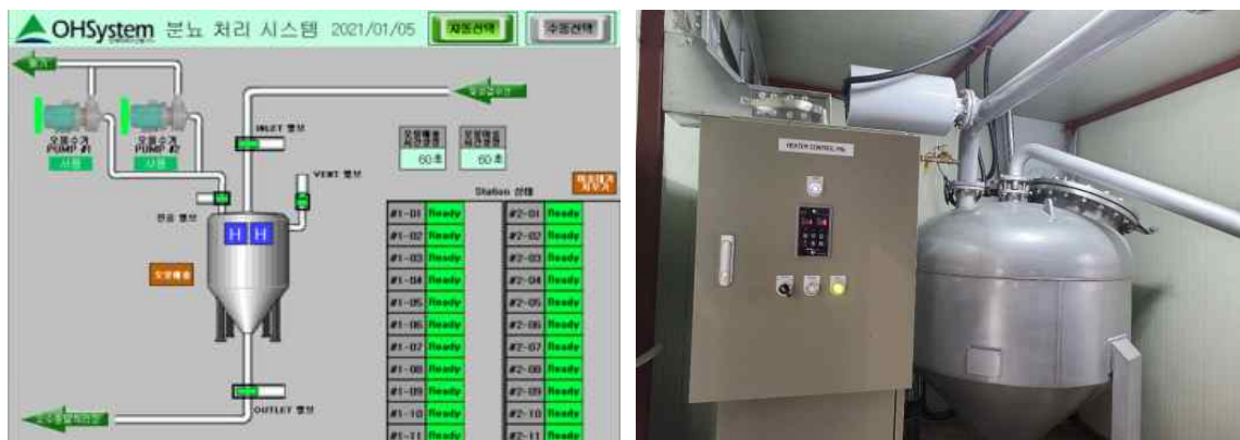
<그림 3> 수도권철도차량정비단 신규설치 오물수거장치('21.1.)
