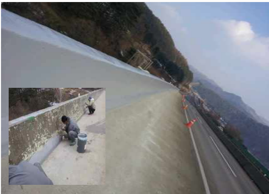
■ 영동선 백옥포교 교량 난간 염해방지 보수공사
