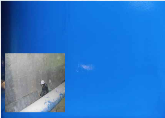
■ 송산 배수지 확장공사
