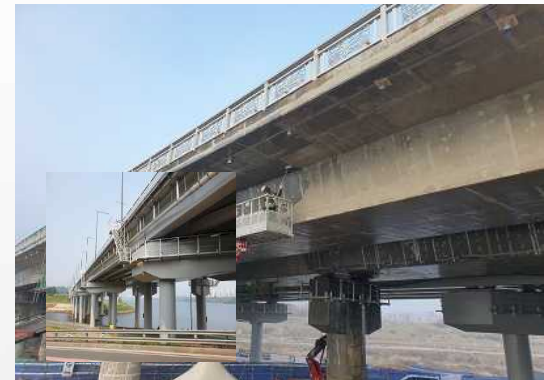
■ 다산신도시 지구외도로 확장 공사(수석교)
