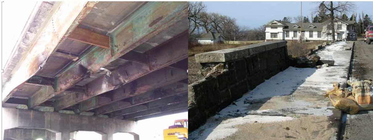
그림 8. 미네소타주 트럭 충돌로 인한 상부 구조 및 난간 손상의 예.
