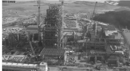
그림 23 한국 1호기 석탄 300MW급 IGCC 태안건설 현장
