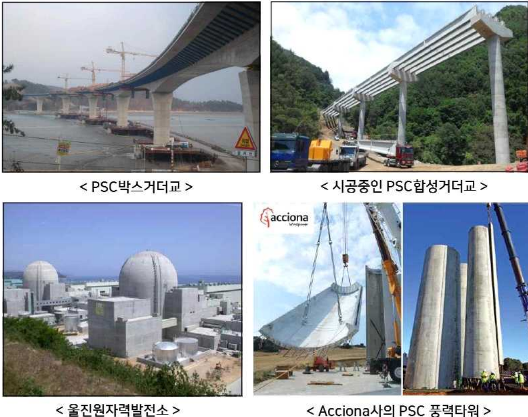
그림 5. 프리스트레스트 콘크리트 구조의 다양한 시설물들
