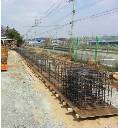
(a) 철근 조립
