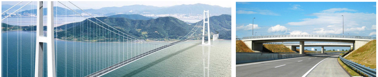
그림 3. 케이블지지교량 및 프리스트레스트 콘크리트 교량
