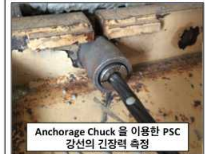
PSC 강선의 긴장력 측정
