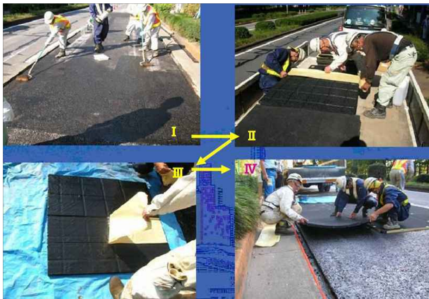
그림 73 아스팔트 매트를 이용한 응급보수 공법
