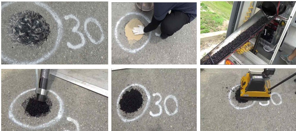
그림 70 상온 급속보강 재료 현장 적용 시험
