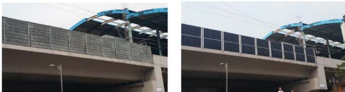
[그림 2] 노후화된 방음벽을 태양광발전 설비로 교체한 사례
