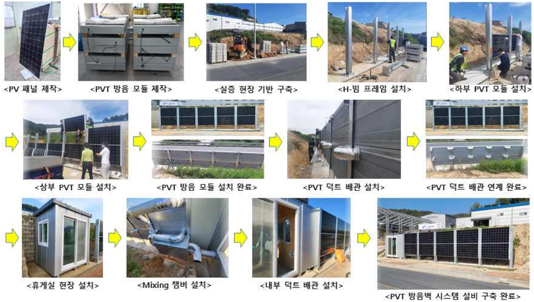
[그림 53] PVT 방음벽 시스템 실증 현장 설치 순서
