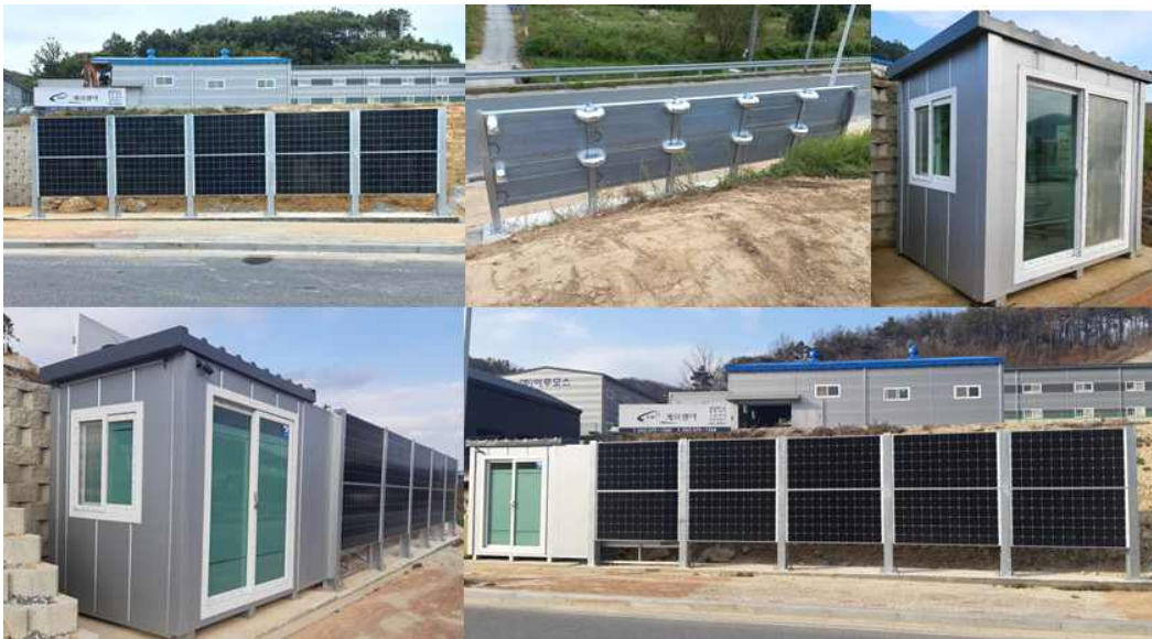
[그림 51] PVT 방음벽 시스템의 전체 사진 및 전경
