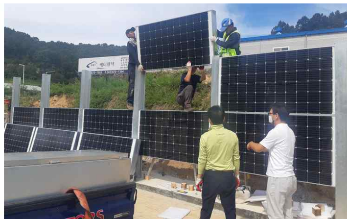
[그림 52] PVT 방음 모듈 현장 시공 (기존 노후 방음벽 교체 및 유지보수 용이)
