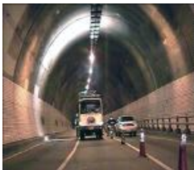
(d) 터널 균열계측 안전진단 공사
