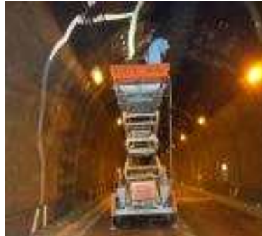
(b) 유압장비 이용 터널 보수공사
