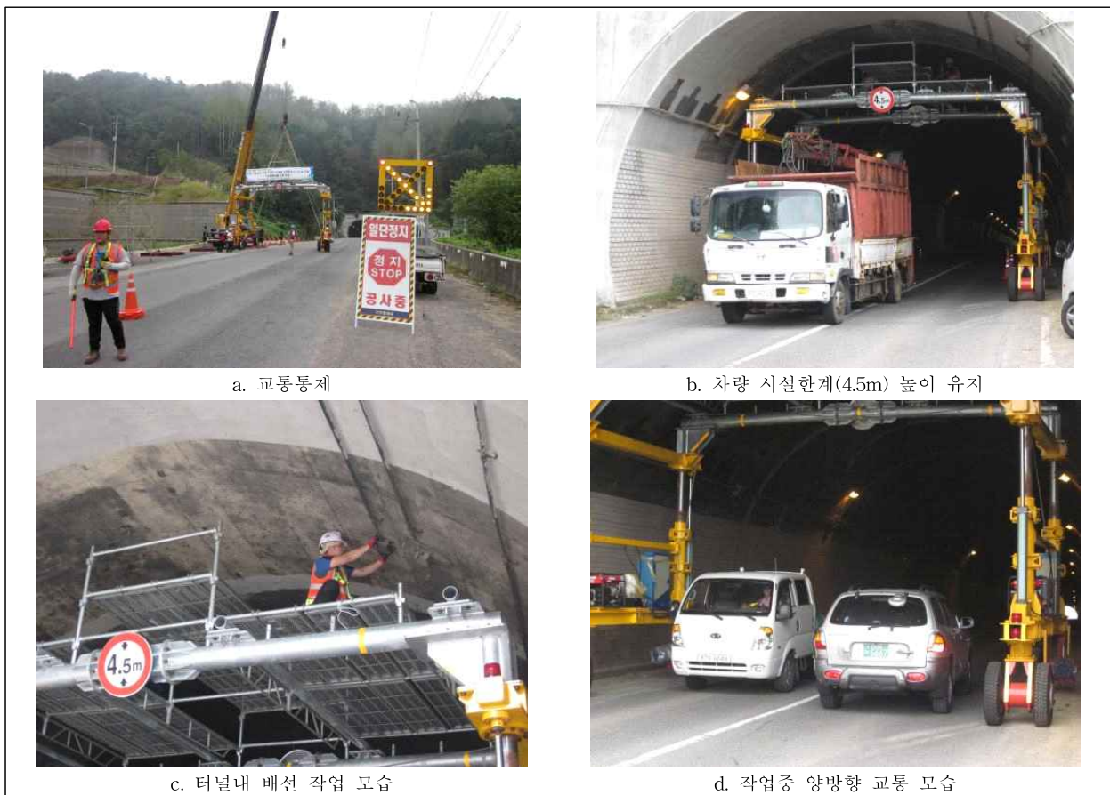
<그림 4-6 가설시스템 터널 시공모습>
