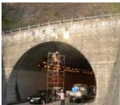
(a) 성남 운중터널(2007) 보강공사
