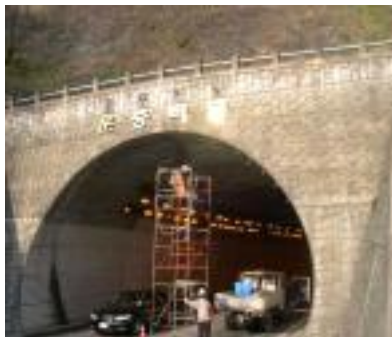
(a) 성남 운중터널(2007) 보강공사
