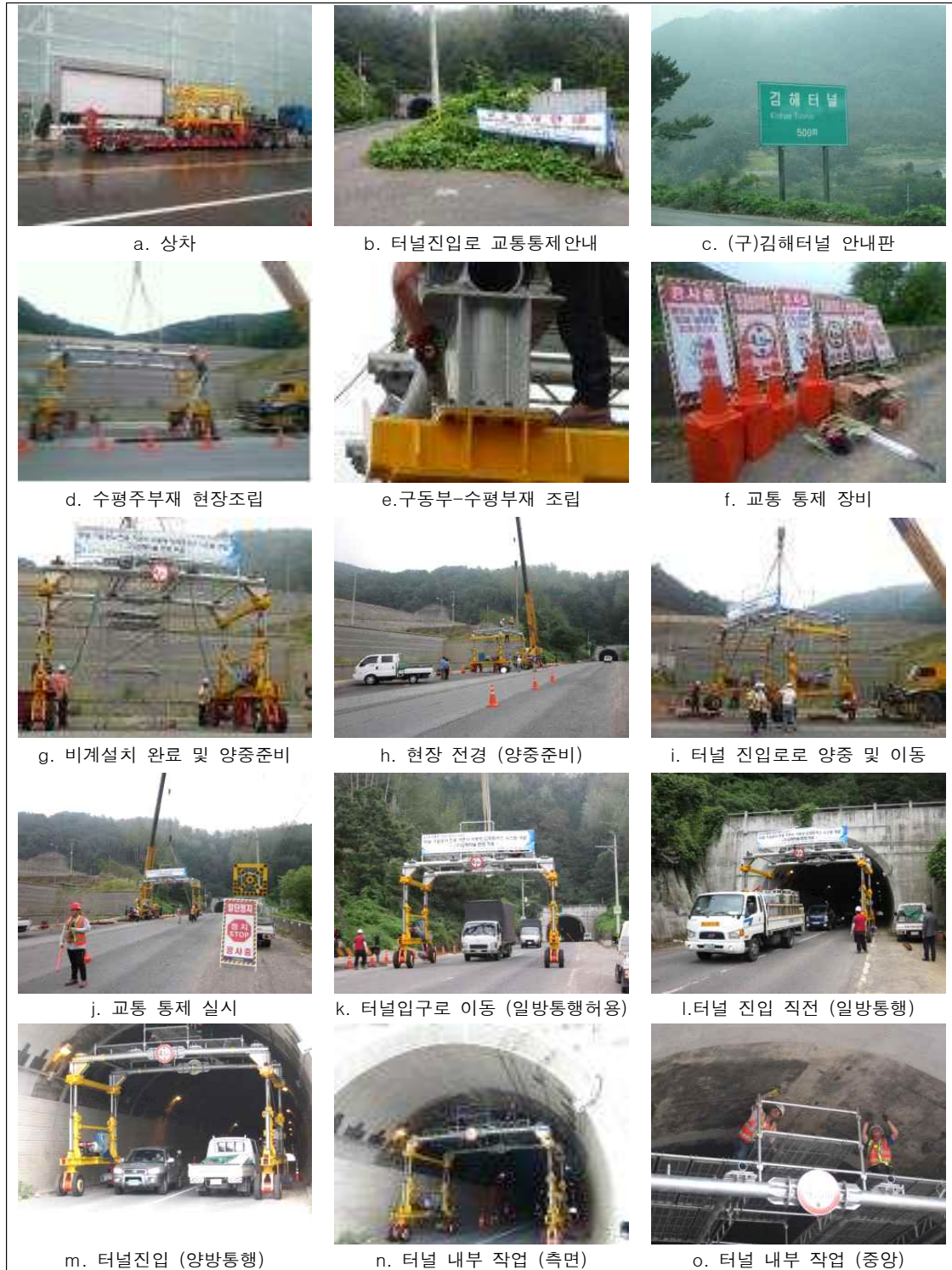
<그림 13-6 입체트러스 터널 현장 적용 관련 사진>
