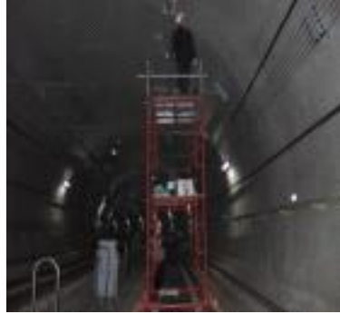
(e) 도시철도 터널 보수공사
