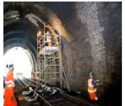
(f) 일반철도 터널 타일공사
