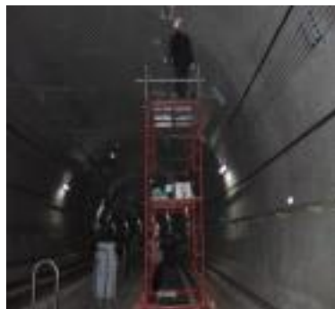
(e) 도시철도 터널 보수공사
