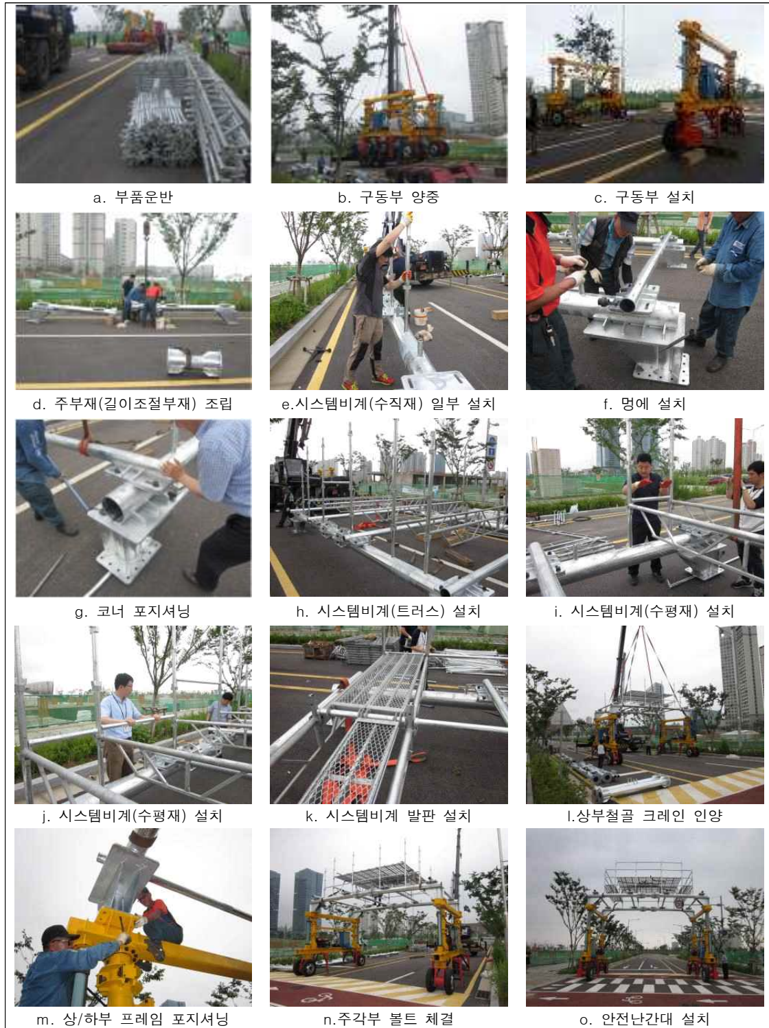
<그림 13-3 입체트러스 조립/설치 순서>
