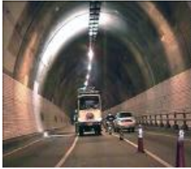
(d) 터널 균열계측 안전진단 공사
