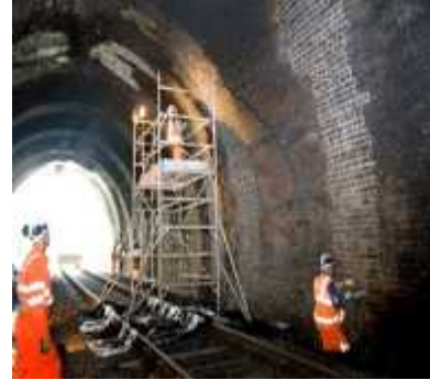
(f) 일반철도 터널 타일공사
