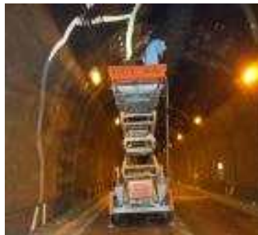
(b) 유압장비 이용 터널 보수공사
