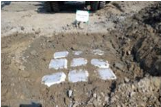
(e) 팽창매트 보강 전경
