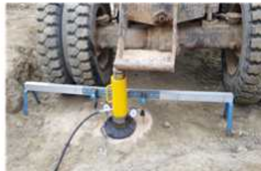
(h) 평판재하시험 전경
