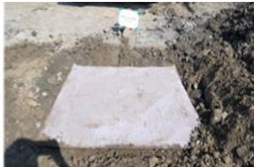
(f) 시멘트매트 보강 전경
