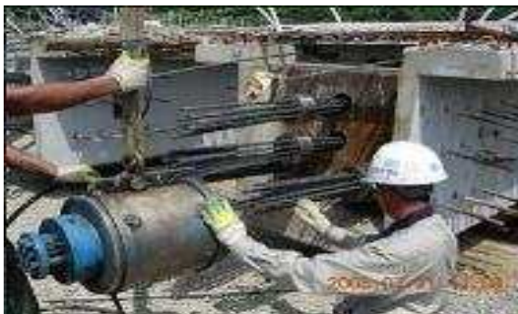
<PSC 시공중 잭킹작업>
