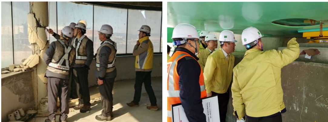
그림 2.4 포항지진(2017) 후 건축물 및 교량의 현장점검 현황
