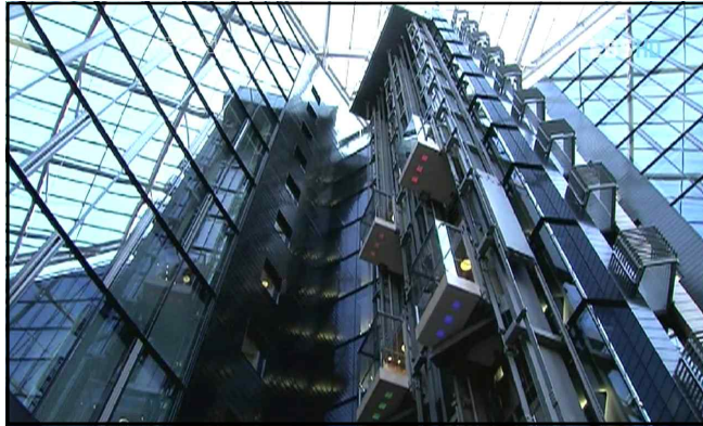
<그림 2-25> 독일 프랑크푸르트 메인트라이앵글빌딩의 트윈엘리베이터
