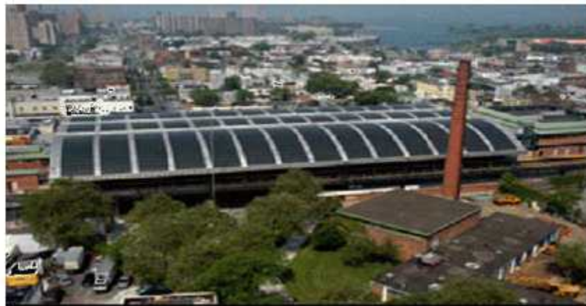
<그림 2-12> 뉴욕지하철 Coney Island Still Well Avenue역 외부 지붕 태양전지판
