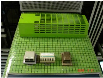
<그림 2-7> 지하철역사의 미생물 번식 예방 정화장치 및 광코팅기술-홍콩지하철
