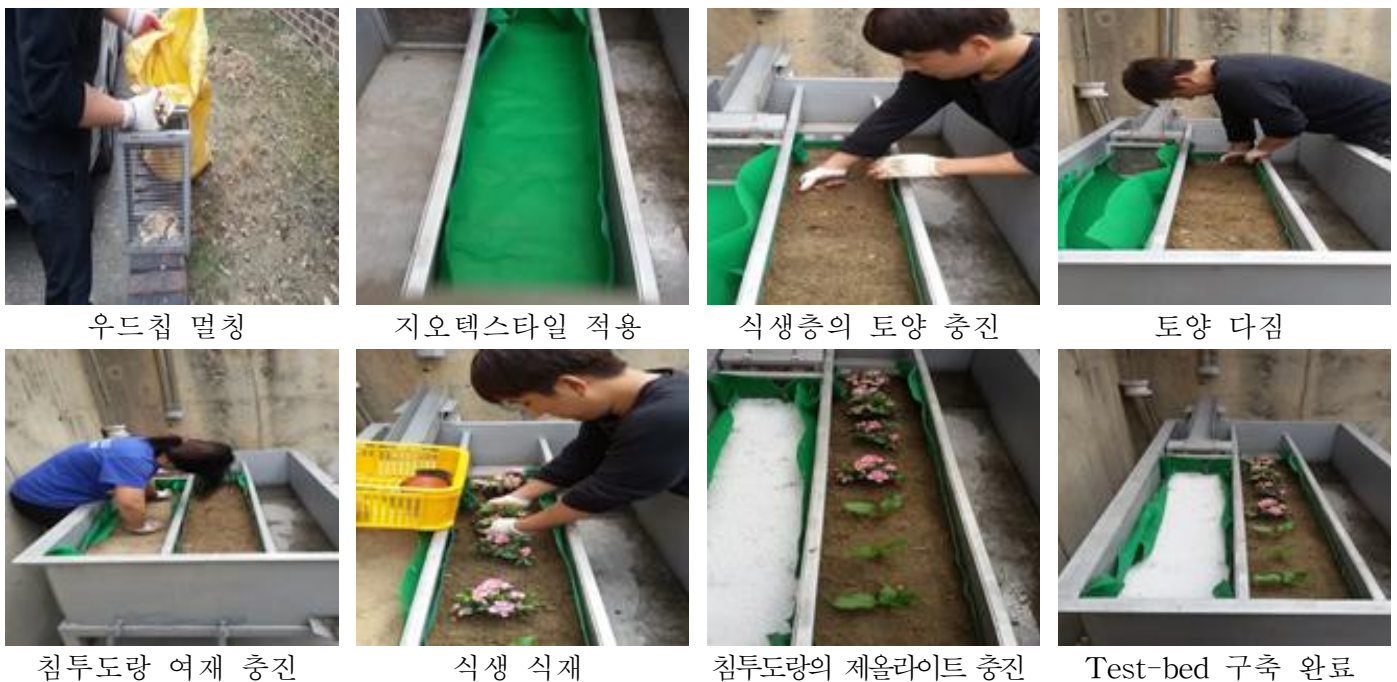
그림 3.1.53 Test-bed 설치 과정
