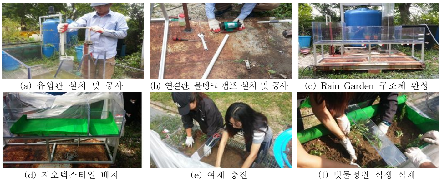
그림 3.1.29 Pilot Plant 설치 과정
