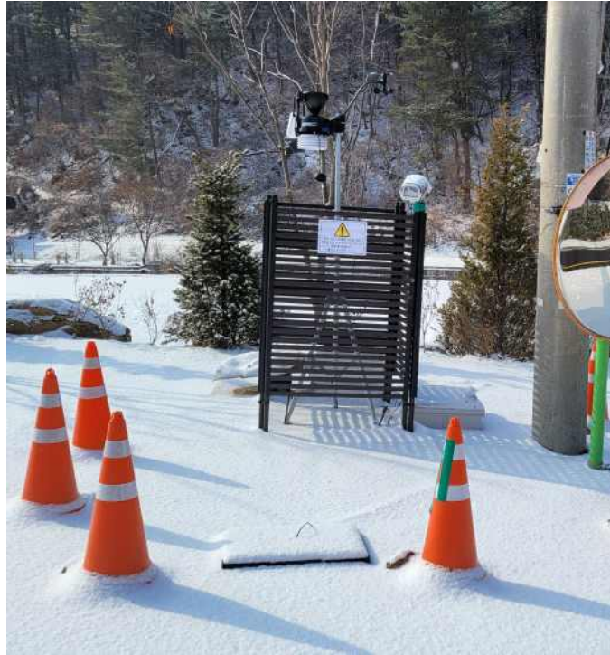
< 기상관측장비 설치 사진 >
