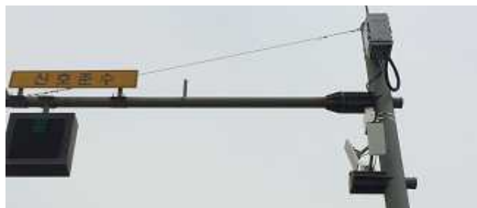
<그림 12> WAVE노변기지국 설치 예
