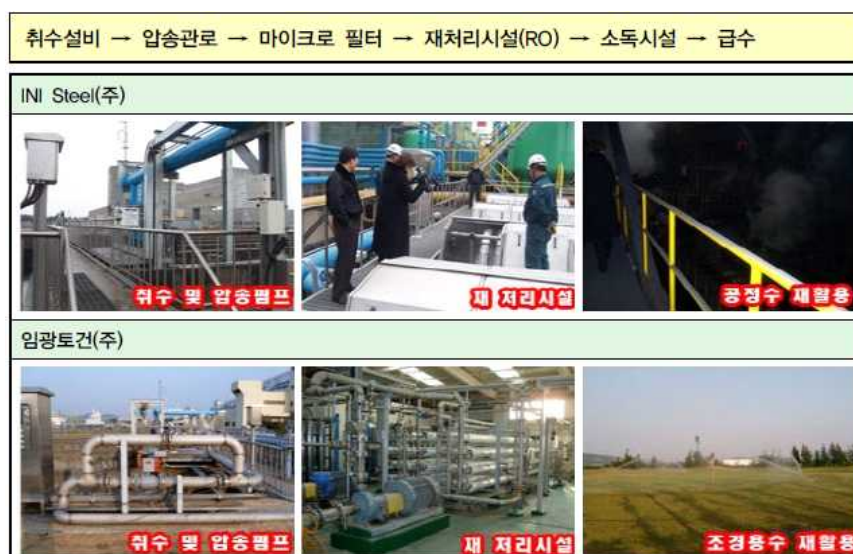
[그림 11] 가좌하수처리장 처리수 공급 및 재처리 과정
