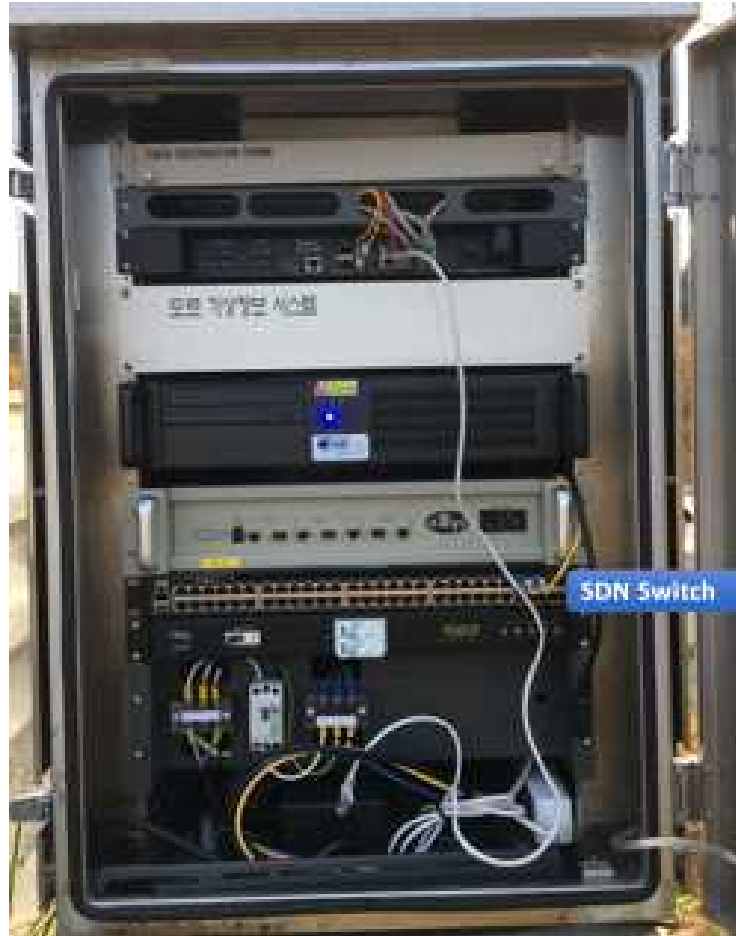
그림 19 스마트 자율협력주행 통합 제어기 - SDN 스위치 구축
