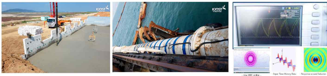
[그림 4.40] 한국해양과학기술원에서 개발한 경량고화처리토 및 EMF를 이용한 준설토 장거리 이송기술
