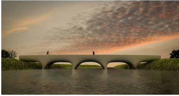
[그림 4.7] 네덜란드(좌)와 중국(우)의 3D 프린터를 이용한 콘크리트 교량
