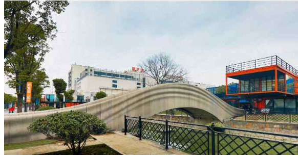
[그림 4.7] 네덜란드(좌)와 중국(우)의 3D 프린터를 이용한 콘크리트 교량
