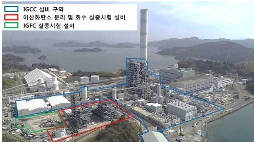
[그림 4.9] 주고쿠전력 오사키발전소 부지 내 IGFC 실증사업 설비 배치도
