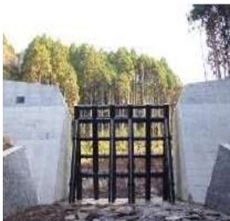
[그림 2.3] 기존의 제방 시설에 투과형 제방 등의 정비 사례
