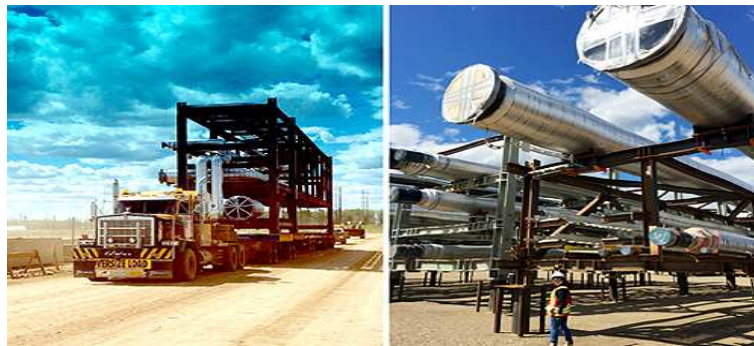
자료: 한국건설신문, 'SK건설, 캐나다 최대 오일샌드 플랜트모듈 이송완료!'
