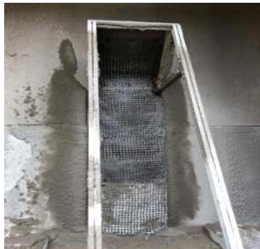
(e) 섬유 그물망 설치 완료
