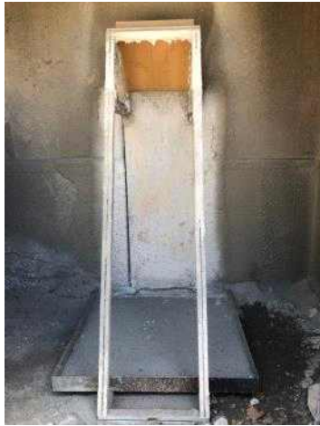
몰드 및 steel sheet 설치
