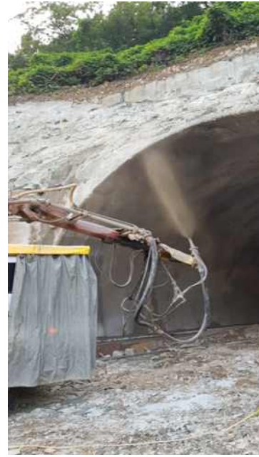
천단부 2차 췁크리트 타설
