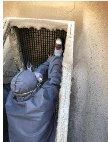
섬유 그물망 설치
