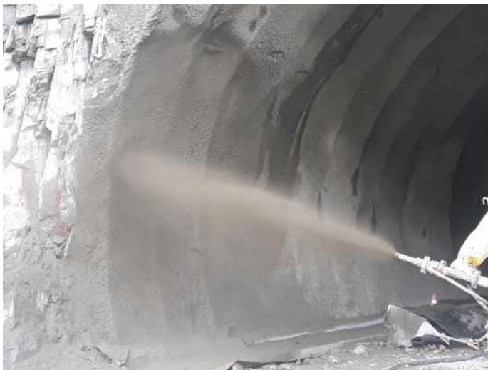
그림 2-63. Section 1에서의 2차 췁크리트 타설
