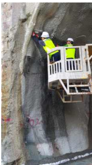
측벽부 섬유 그물망 설치
