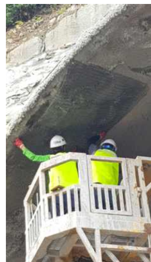
천단부 섬유 그물망 설치
