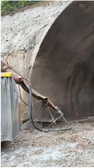
측벽부 2차 췁크리트 타설
