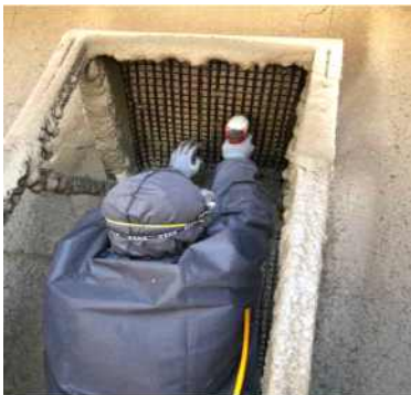
(d) 천단부 섬유 그물망 설치
