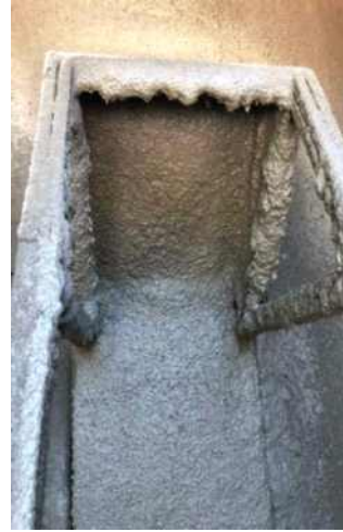
터널 천단부 모사 시공 완료 모습
