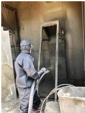
2차 콘크리트 타설
