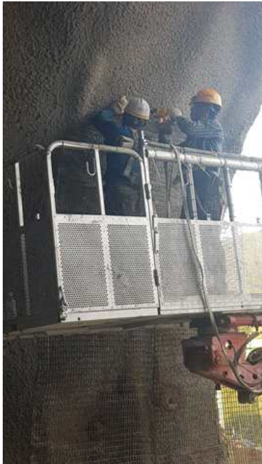
핀을 이용한 섬유 그물망의 상부 고정
