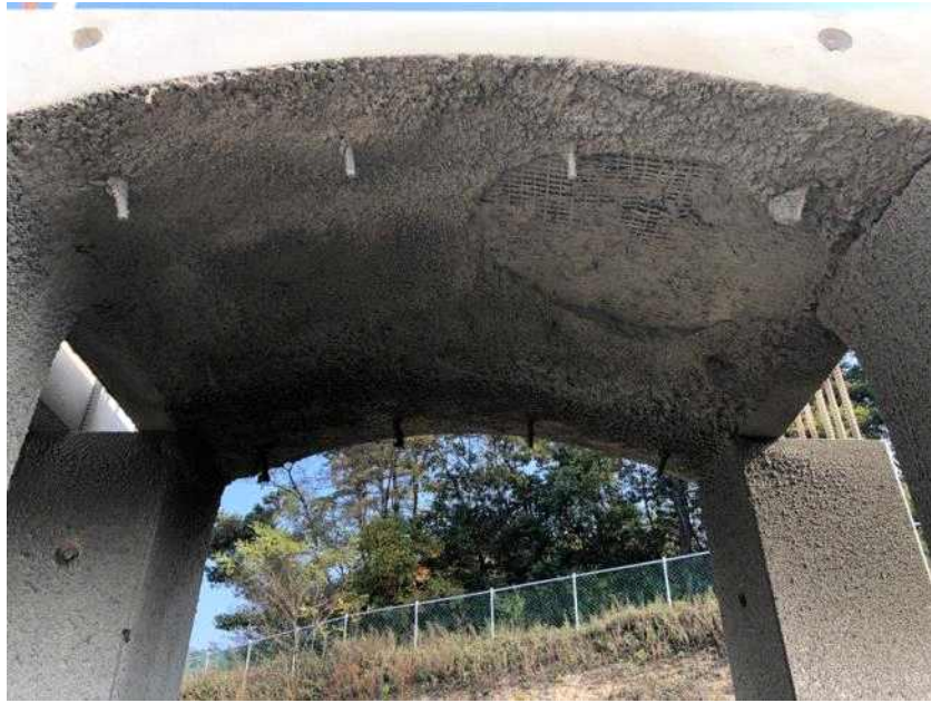
그림 2-43. Section 3에서의 2차 췁크리트 탈락 단면 형상
