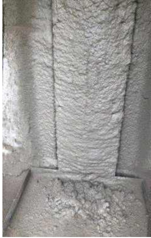
터널 측벽부 모사 시공 완료 모습
