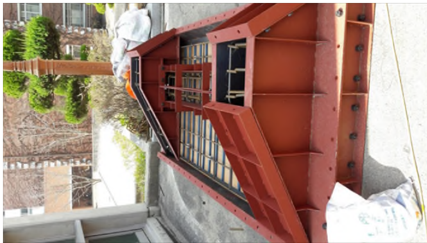
[그림 22] 상부 거더 소피트 실물 몰드 전경
