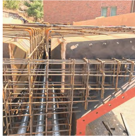
(b) 철근 조립
