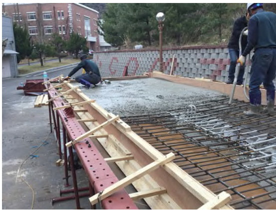
(c) 콘크리트 타설
