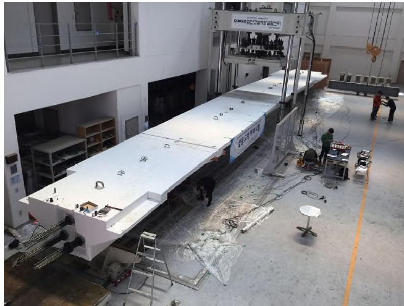
[그림 29] 시제품 설치 완료 후 전경 사진
