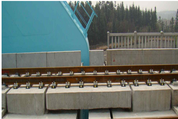
그림 4 교량신축이음부 횡단궤도시스템(Switch bridge구조, 패널형식) 시공사례
