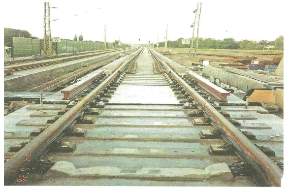
그림 4 교량신축이음부 횡단궤도시스템(Switch bridge구조, 패널형식) 시공사례
