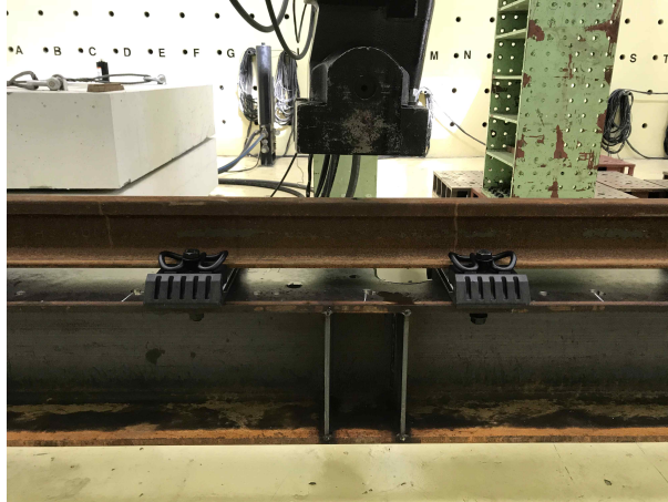
그림 85 하중재하위치 스티프너 설치
