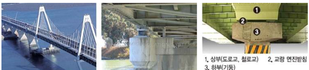
<그림-30> 교량 면진시스템 적용 예시
