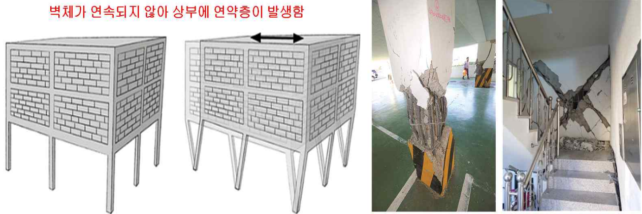
<그림-7> 필로티 구조의 취약점 발생에 따른 피해(파손) 부위
