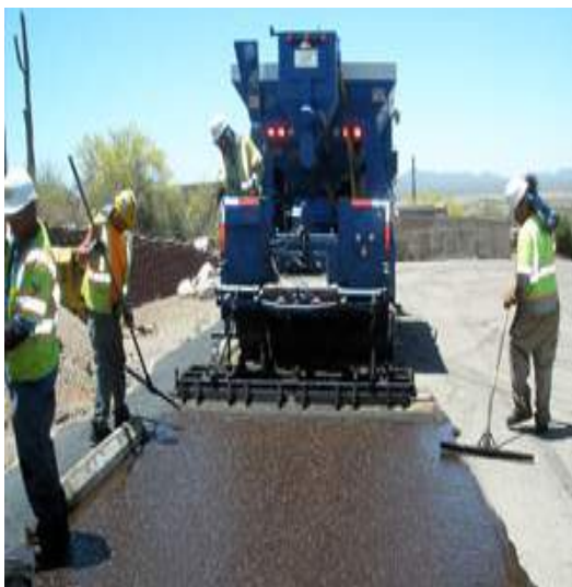
<그림 80> Slurry Seal 공법
