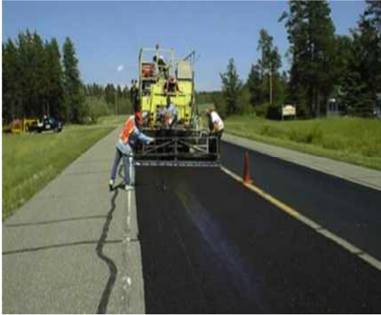
<그림 81> Micro Surfacing
