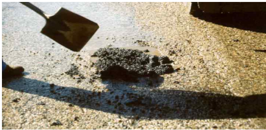
〈그림 8〉 Throw-and-Roll 공법
