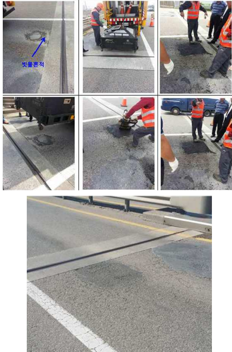
<그림 71> 장흥교 시공현장 (상), 시공 10개월 경과 (하)
