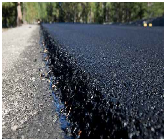
<그림 82> Thin Hot-Mix Overlays
