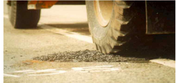
〈그림 8〉 Throw-and-Roll 공법
