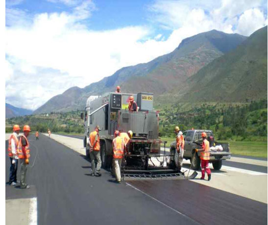
<그림 81> Micro Surfacing
