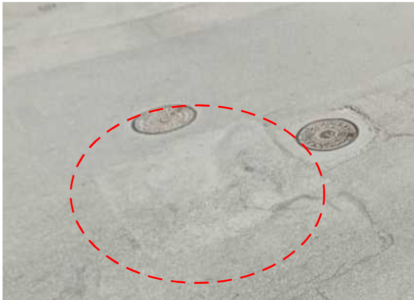
<그림 73> 원주시 시공현장(상), 시공 12 개월 경과 상태 (중), 시공 20 개월 경과 상태 (하)
