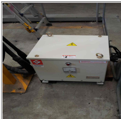
100V 전용 트랜스 설치
