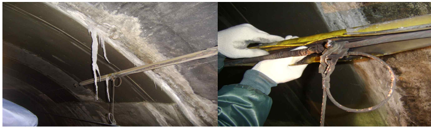
그림 14 터널내 고드름(좌) 및 조가선 소손 현황(우)
