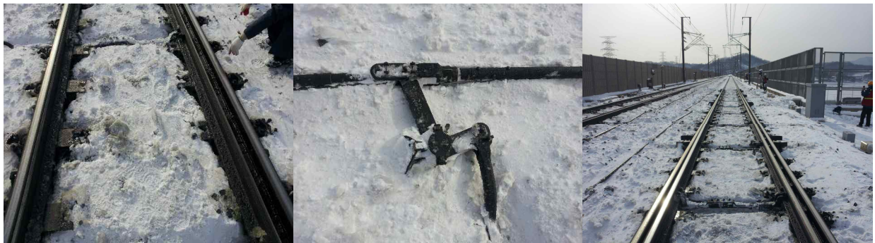
그림 142 선로전환기 장애 발생 시 적설 및 동결 상황
