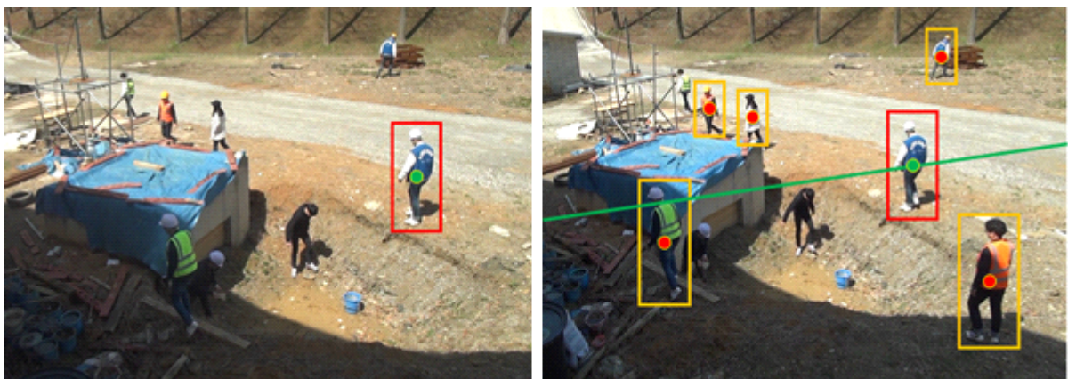
그림 2-30. Epipolar geometry 기반의 Entity matching 결과
