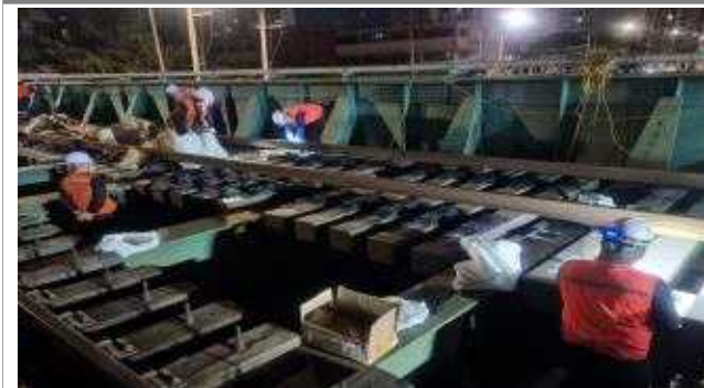
(e) 침목-거더 체결장치 설치
