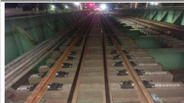
(g) 가드레일 배열, 설치
