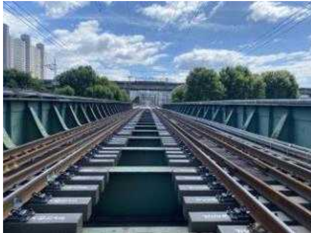
< 현장시험부설 공사 후 >
