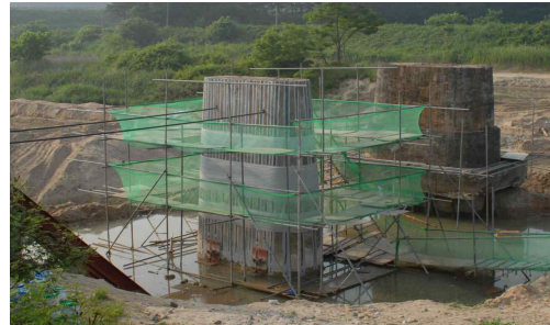
하부구조 보수보강 사례 2
