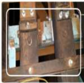
(b) 가변패드 주머니 설치
