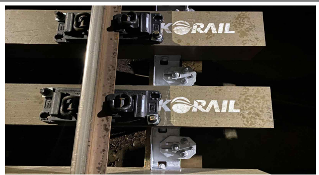
(f) 침목-거더 체결장치 설치 완료
