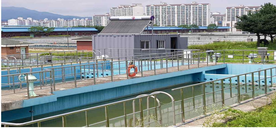
<그림 2.76. 테스트베드 내 막증류 정수처리 시스템 파일럿 플랜트 설치>
