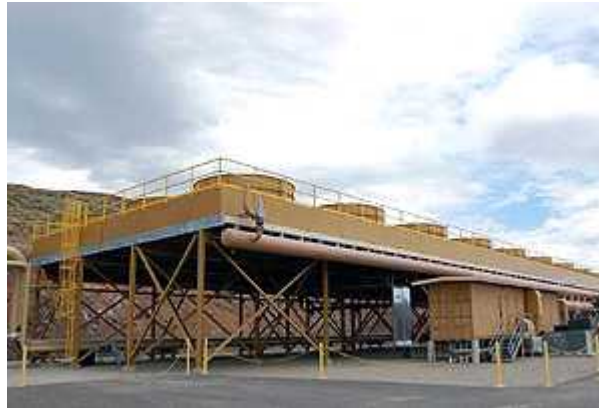
< 그림 1.3. 미국 네바다주 리노에 설치된 지열을 이용한 MD 공정 파일럿 설비 >
