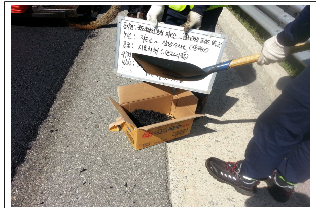
<그림 17> 시료채취(가열 아스팔트 혼합물)
