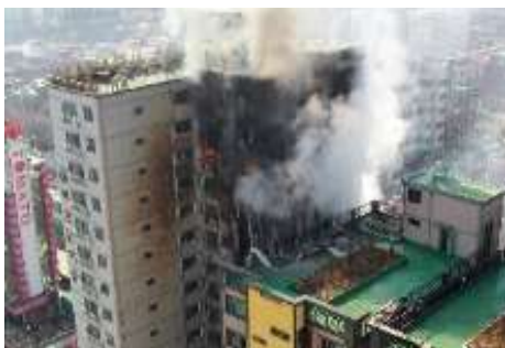
(a) 외벽 단열재로 인한 화재 확산
