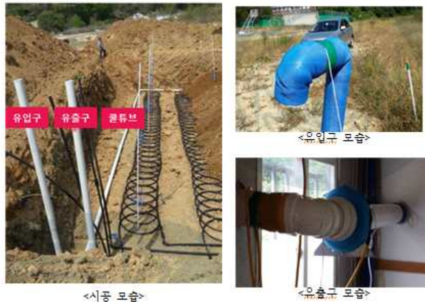
[그림 2-16] 열교환기 시공 모습
