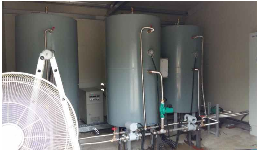
[그림 3-95] 물 배관 순환펌프 시스템 작업
