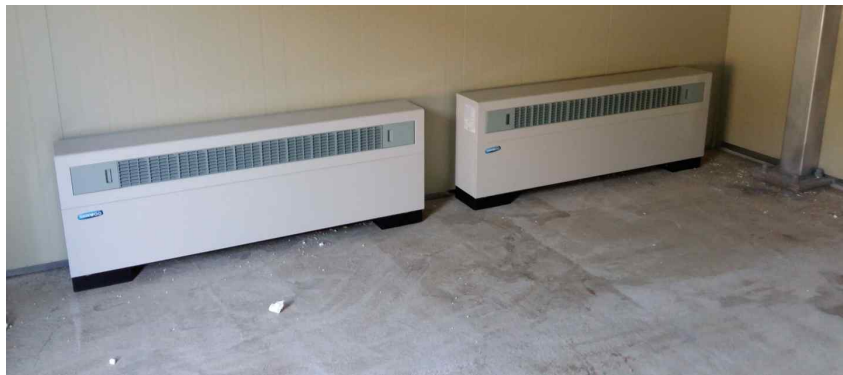
[그림 3-93] FCU 설치
