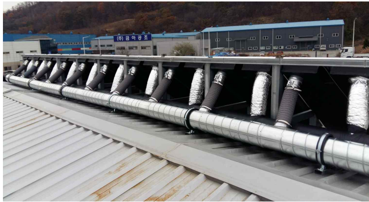
[그림 3-73] PVT 배관 설치 (지붕)
