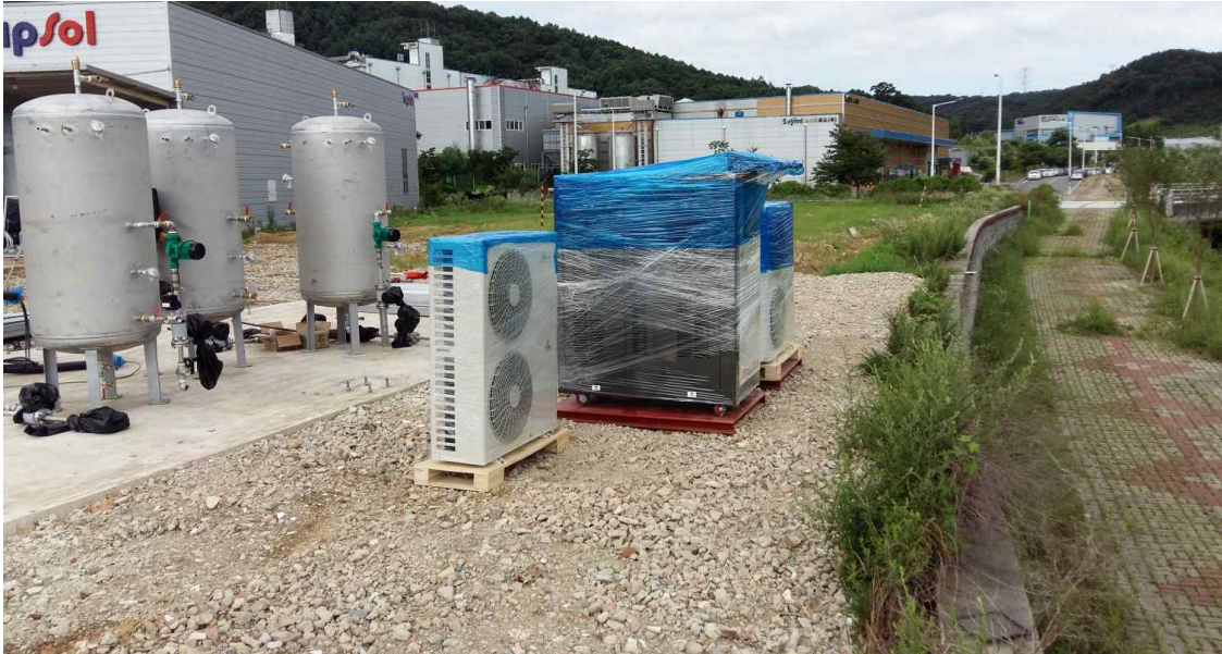
[그림 3-82] 히트펌프 및 칠러 안착
