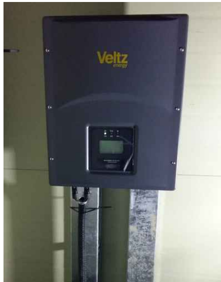
[그림 3-71] INVERTER 설치
