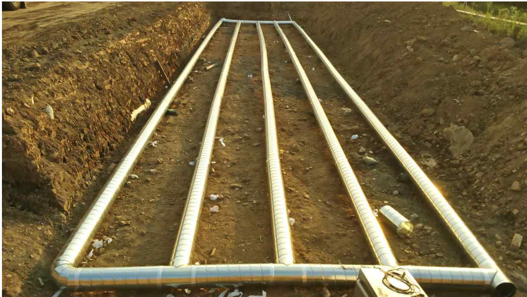
[그림 3-77] GAHX 지중열교환기 시공
