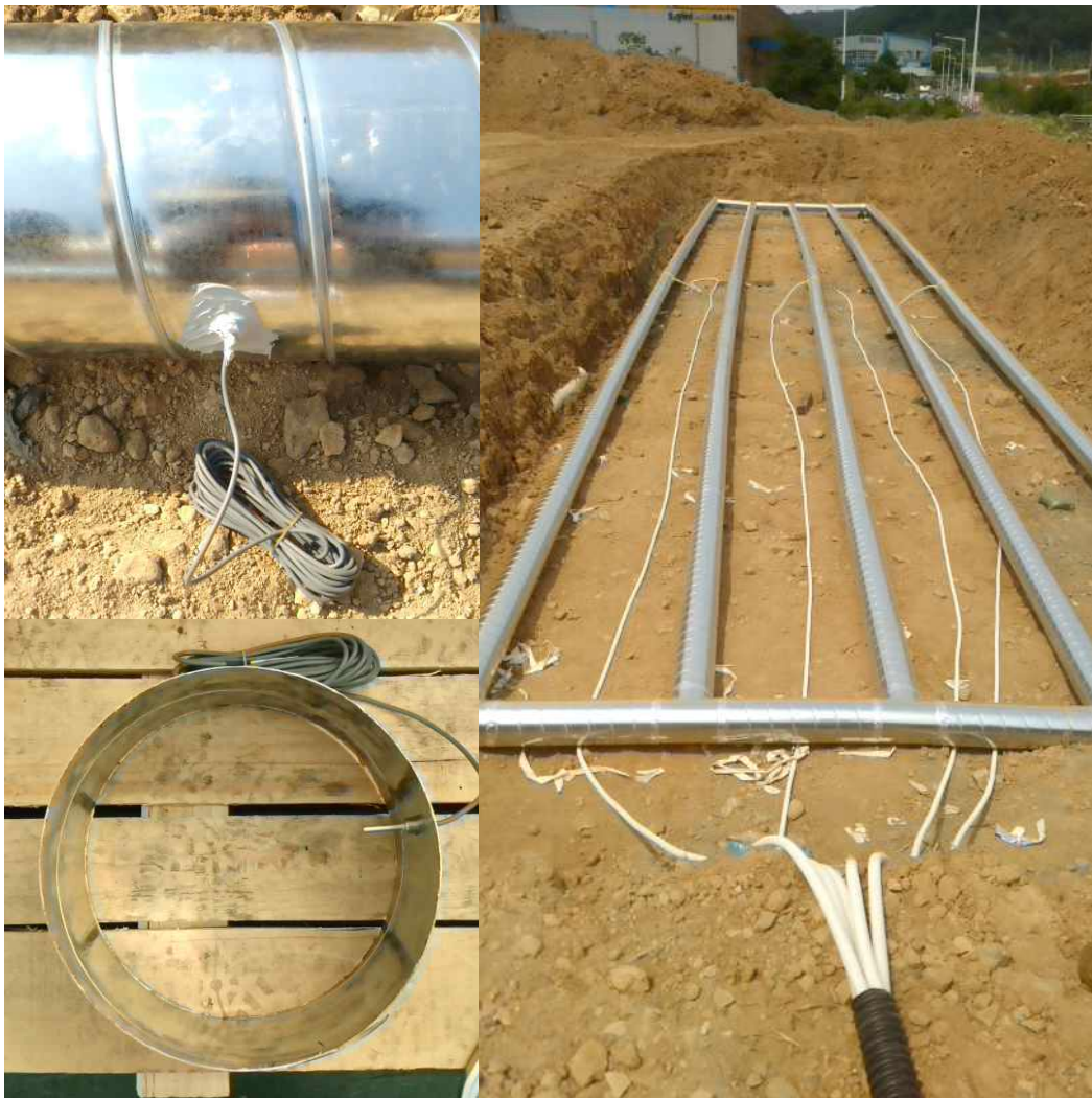
[그림 3-78] GAHX 지중 열교환기 및 지중 온도센서 포설
