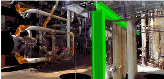
<독일 Fargo사의 PointSense S/W와 그리스 ARGO Navis Marine의 DWT Bulk carrier 선내 BWTS 리트로피팅>
