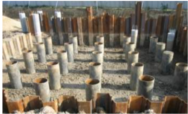
(b) 강관말뚝 시공전경
