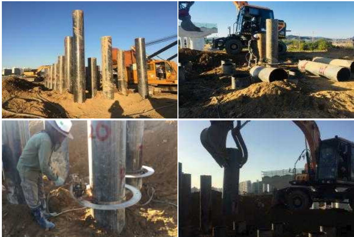
그림 3.30 재래식 방식을 활용한 강관말뚝 두부정리 작업의 생산성 분석
