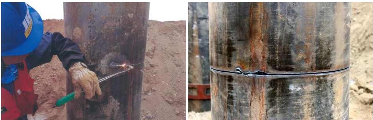
그림 1.8 노무자 직접절단 작업으로 인한 절단작업 품질저하
