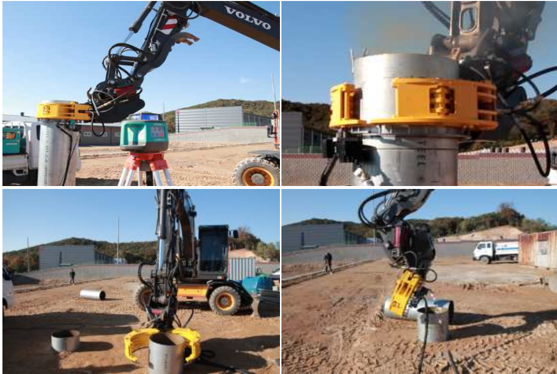
그림 3.31 자동화 방식을 활용한 강관말뚝 두부정리 작업의 생산성 측정 실험
