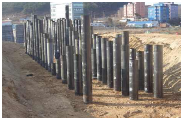
(b) 노출된 강관말뚝 상부 높이
