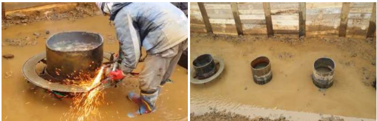
그림 1.6 수몰된 강관말뚝 두부정리 작업현장
