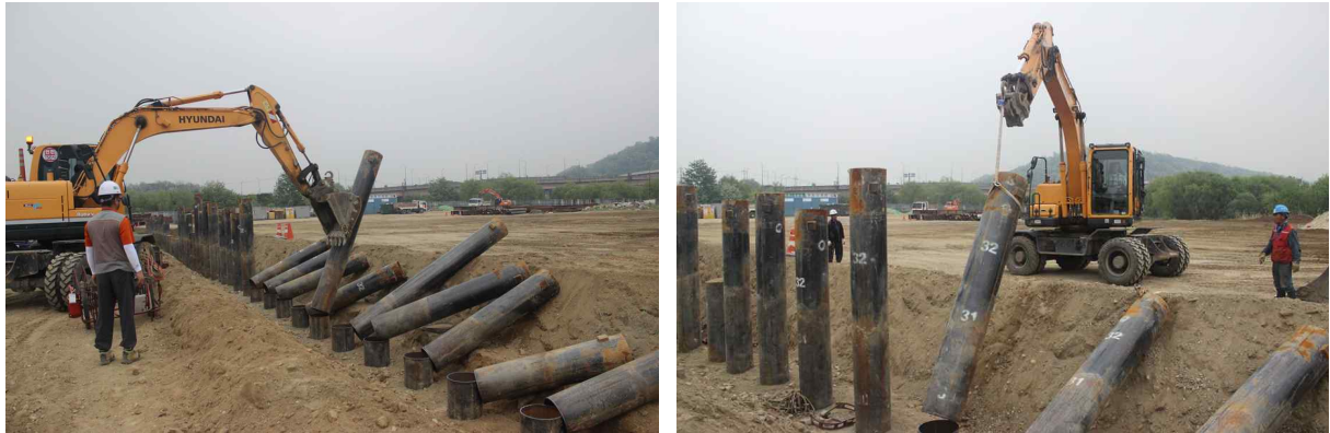
그림 1.7 굴삭기만을 활용한 강관말뚝 전도 및 인양 작업
