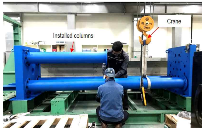
(b) 지지판 연결 기둥 설치
