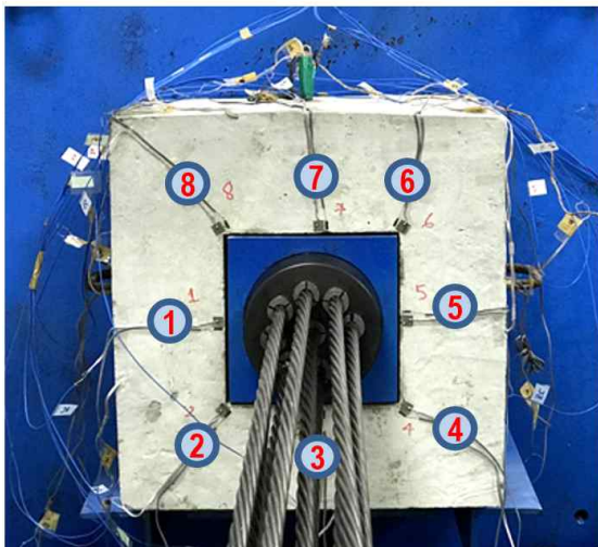
(a) 콘크리트 정착부 표면의 PZT 센서 설치
