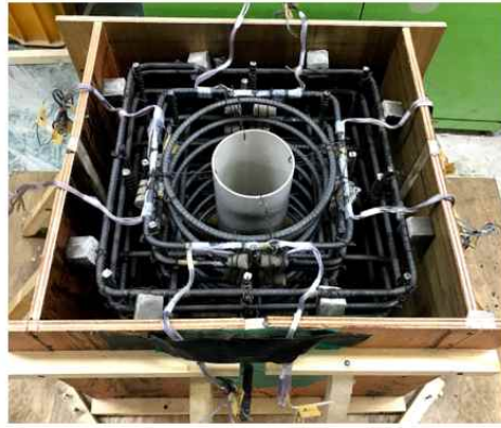
(b) 내장 센서 설치 및 철근-거푸집 결합
