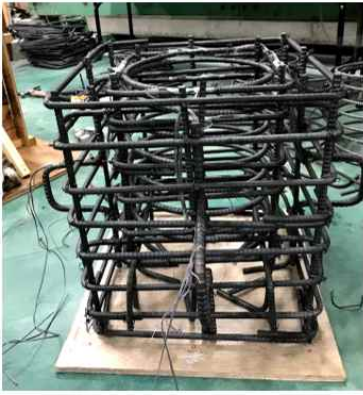
(a) 철근 조립
