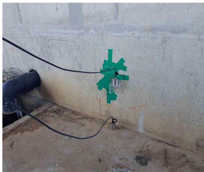
[그림 2-59] 가속도계의 설치 및 계측
