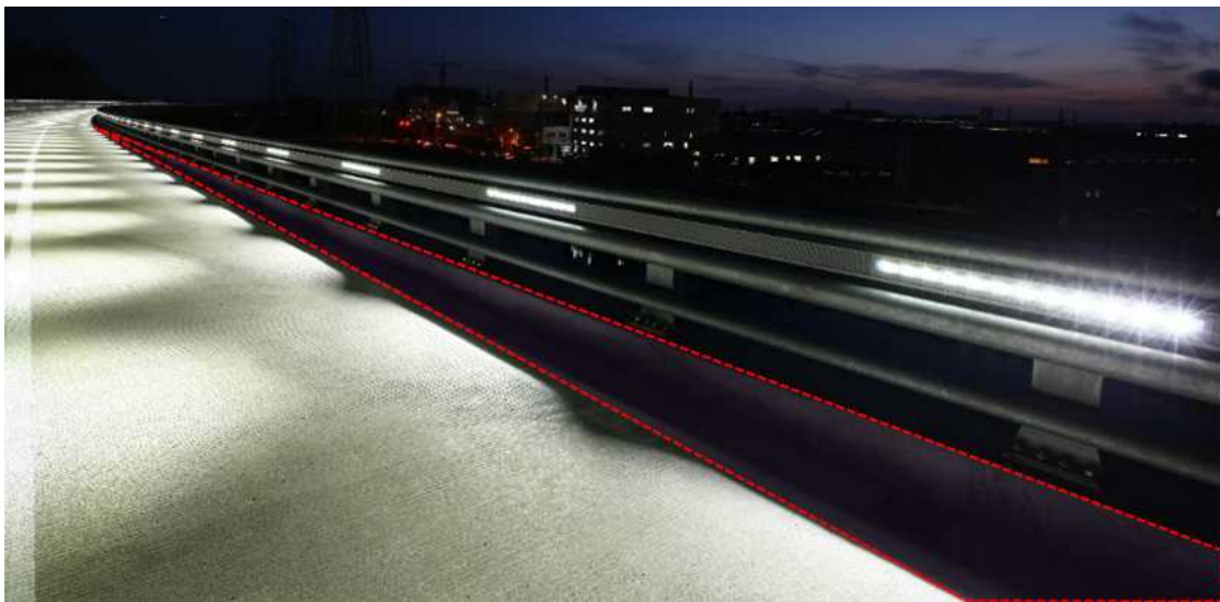
<기 개발 낮은 조명의 단점 : 등기구 근접 하단부 음영지역 발생>
