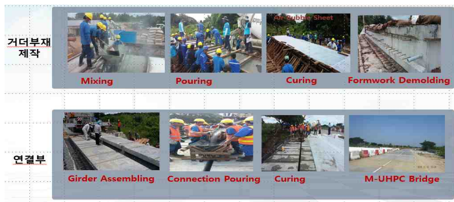
[그림] 미얀마 M-UHPC 교량 건설 모습
