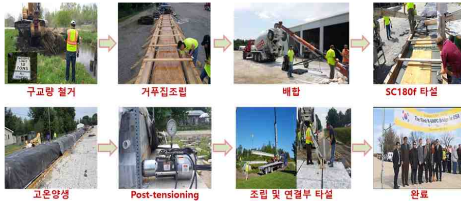
[그림] 미국 Hawkeye UHPC 교량 건설 모습
