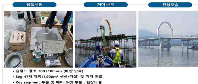
[그림] 춘천대교 타설 및 교량 건설 모습
