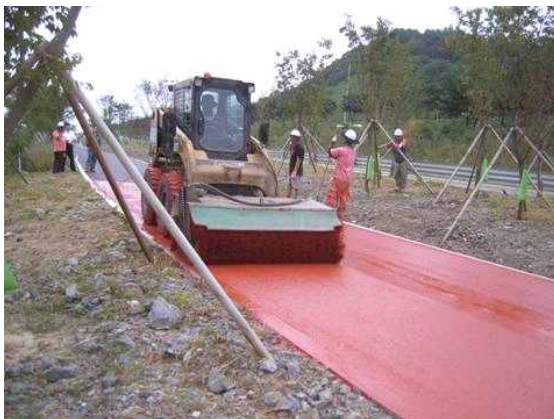
c)버킷을 이용한 페이스트 주입
