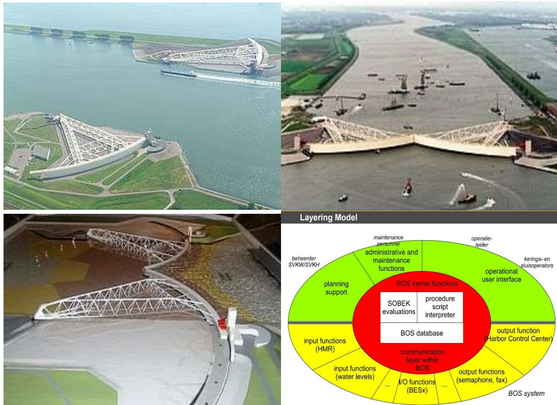
[그림 28] Maeslantkering 하굿둑과 시스템개요도
