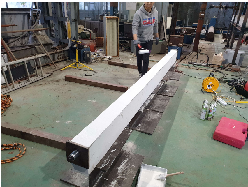
그림 100. 폐교량 대체용 PSC 거더 거치 모습
