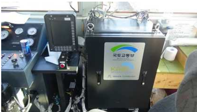
그림 81 전철처 모터카에 ATP 차상장치 설치 사진
