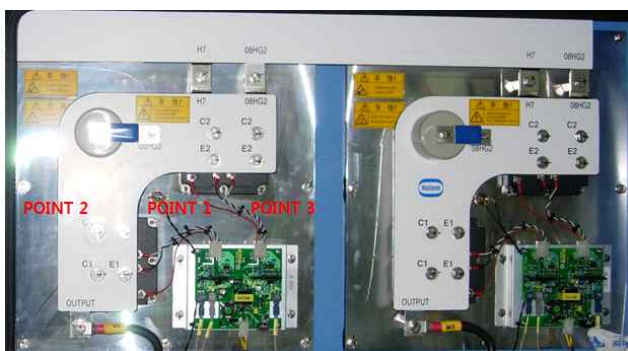
〈그림 2-4-6〉 보조전원장치 온도 측정 위치
